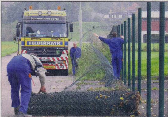
Alles muss weichen: Damit der 240-Tonner problemlos zur Anlegestelle kann, werden Zäune und Balken entfernt.
